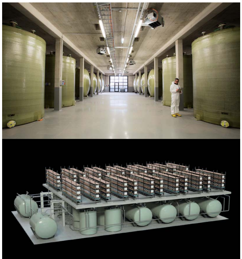
Bild 3: Die beeindruckenden Redox-Flow-Akkueinheiten von „Redox Wind“ sind in einer riesigen Halle installiert und liefern bis 2 MW Leistung auf Abruf. Bild/Screenshot: Fraunhofer ICT
