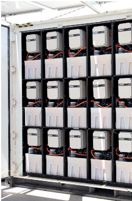
Bild 5: Eine Solar-Redox-Flow-Einheit in der Referenzanlage von Redflow mit 15 ZBM2. Bild: Redflow
