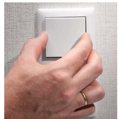
Bild 18: Abschluss der Installation: Einsetzen der Tasterwippe
