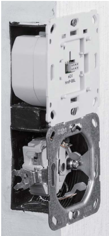
Bild 25: So erfolgt die Montage in eine Unterputzdose.
